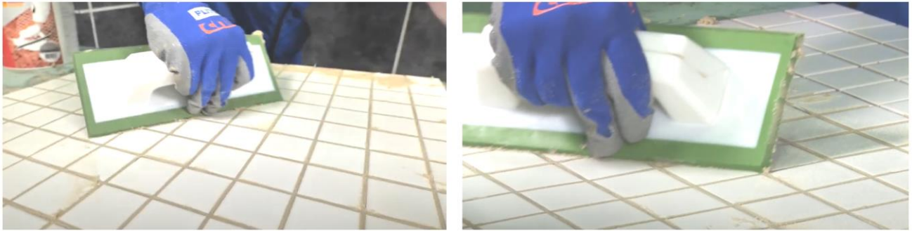
Рис. 33. Диагональными движениями шпателя убрать с поверхности плитки излишки затирки
