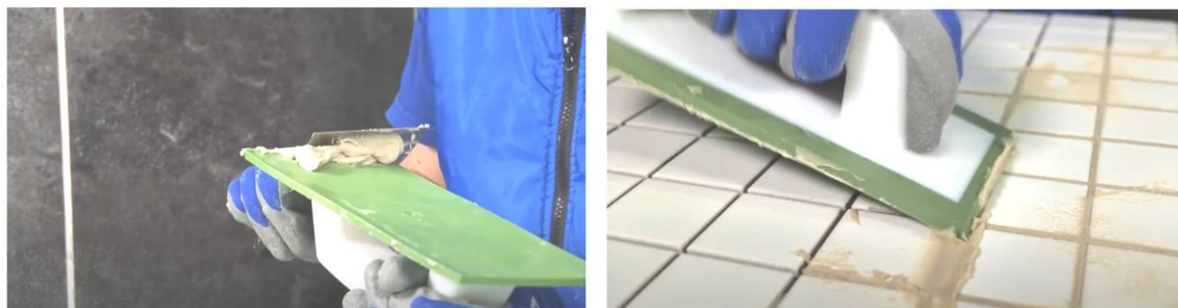
Рис. 32. Заполнение швов затиркой при помощи резинового шпателя
